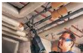
Прокладка водопроводных труб и теплосетей Артикул 0615 . 915 . 029
