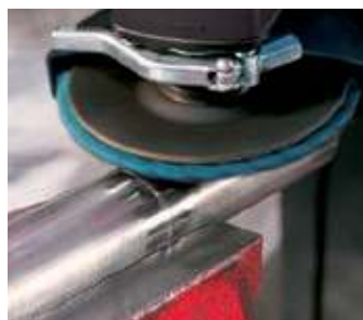
Шлифование сварных швов и удаление цветов побежалости
